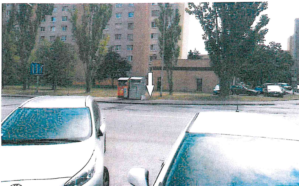
4. Pri križi 9 – rozvodňa (parc. č. 1240/1 reg. C – MAG)
